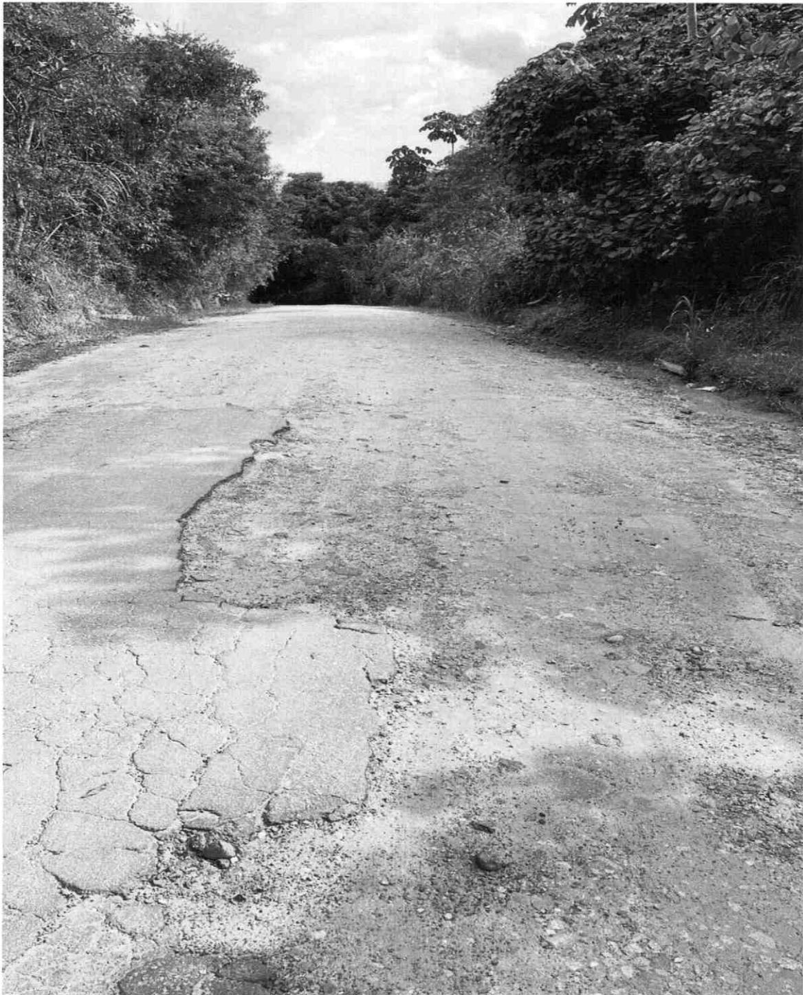
IMPLANTAÇÃO DE GUIAS E SARJETAS EM TODA A EXTENSÃO DA RUA RIKIO SUENAGA, JD. EUROPA – MOGI DAS CRUZES.
